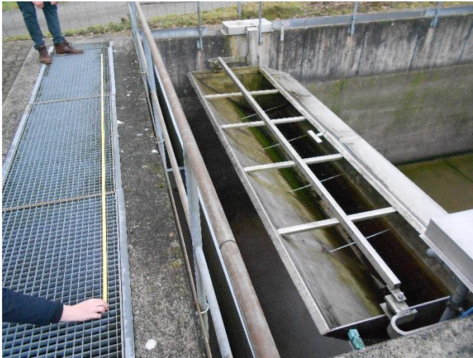
Abbildung 8: Bestehende Spülkippe im RKB 1.
