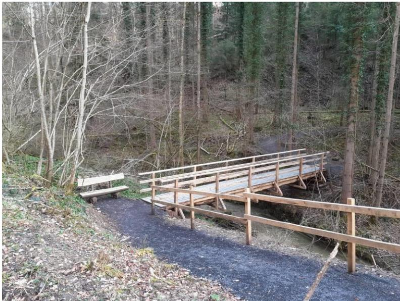
In Untertunkhofen konnten wir im Gebiet Erlitobel die beiden Gemeinden Untertunkhofen und Oberlunkhofen mit einer neuen Fussgängerbrücke aus eigenem Eichenholz verbinden. Etwas speziell an dieser Brücke sind sicherlich die Fundamente, die wir nicht wie üblich aus Beton gemacht haben, sondern ebenfalls aus grossen Eichenklötzen.
